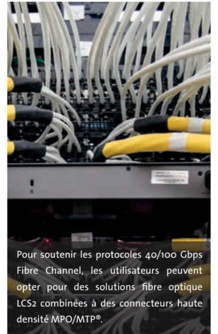
Pour soutenir les protocoles 40/100 Gbps Fibre Channel, les utilisateurs peuvent opter pour des solutions fibre optique LCS2 combinées à des connecteurs haute densité MPO/MTP®.
