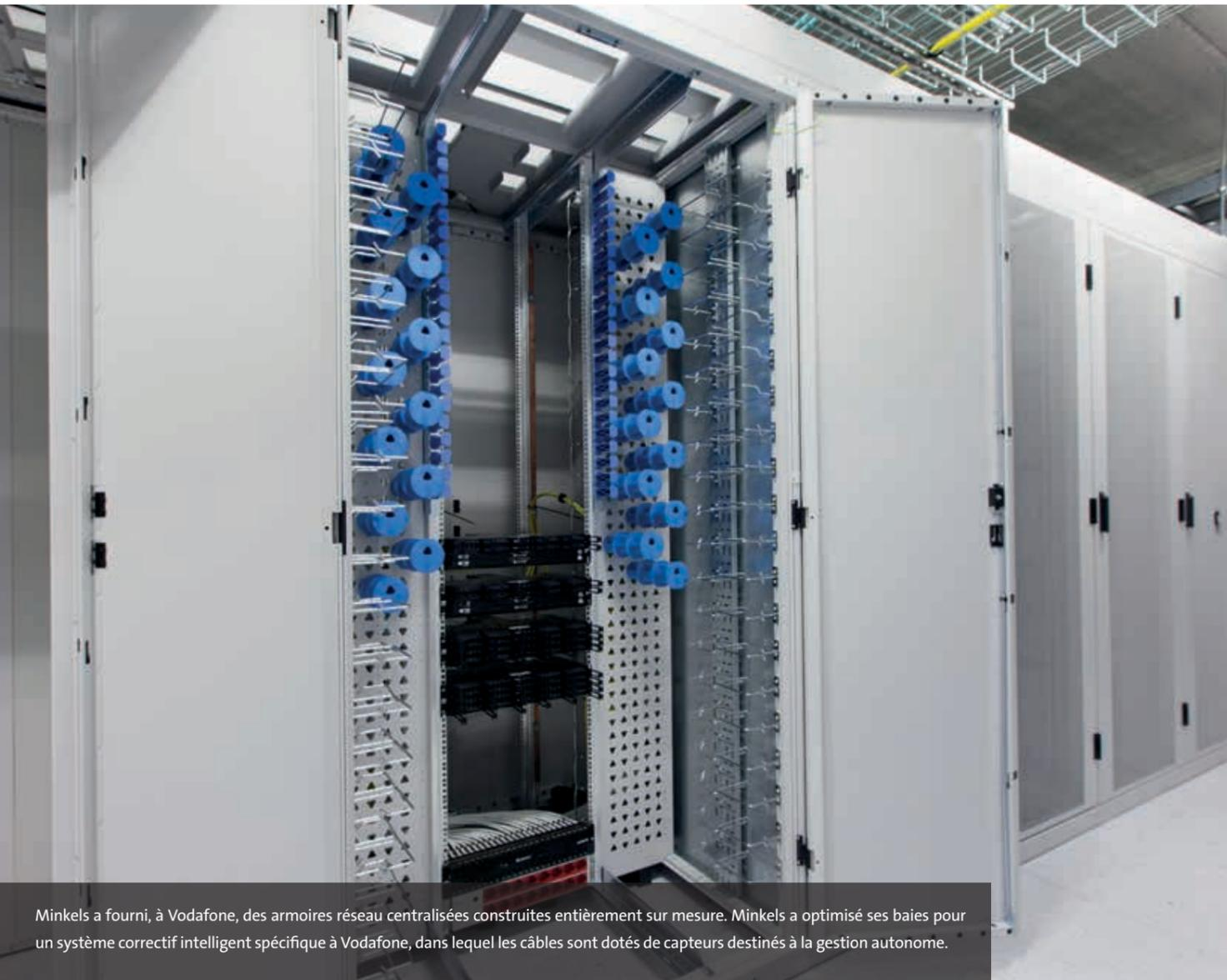
Minkels a fourni, à Vodafone, des armoires réseau centralisées construites entièrement sur mesure. Minkels a optimisé ses baies pour un système correctif intelligent spécifique à Vodafone, dans lequel les câbles sont dotés de capteurs destinés à la gestion autonome.
