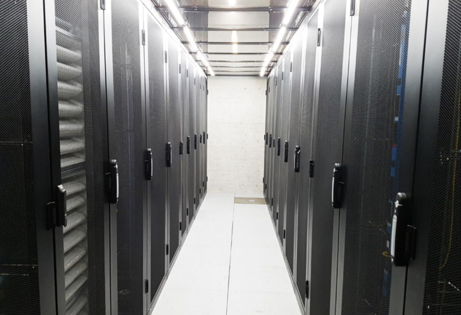
Gemeinsam wurden die passenden Lösungen entwickelt. Die Warmgang-Einhausung mit den Racks nutzt die Raumhöhe aus, die Verkabelung findet von oben statt und vernetzt gemäss FTTO-Konzept alle IT-Nutzer im Gebäude. Für die Energiemessung und die Überwachung von Raumtemperatur, Luftfeuchtigkeit und Luftstrom setzte Minkels intelligente Stromleisten von Raritan ein.
